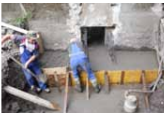
Zsilip műtárgy betonozása
