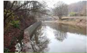
Elsőként a megkerülő csatorna készült el
