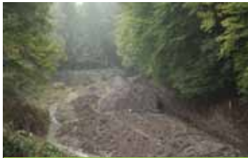
A földmunkák megkezdése után
