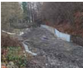
A megkerülő csatorna építés közben
